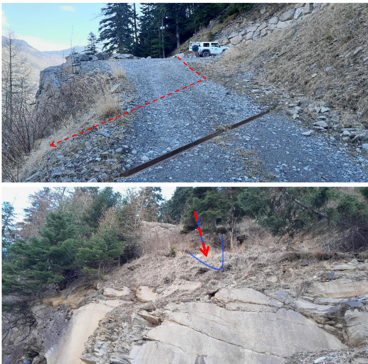
Figure 4 : rejet des drains en arrière du soutènement
