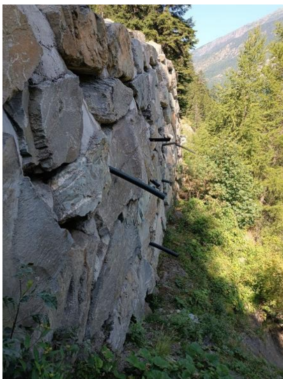
Figure 1 : Vue générale du mur et fissure en crête d'ouvrage en 2023
