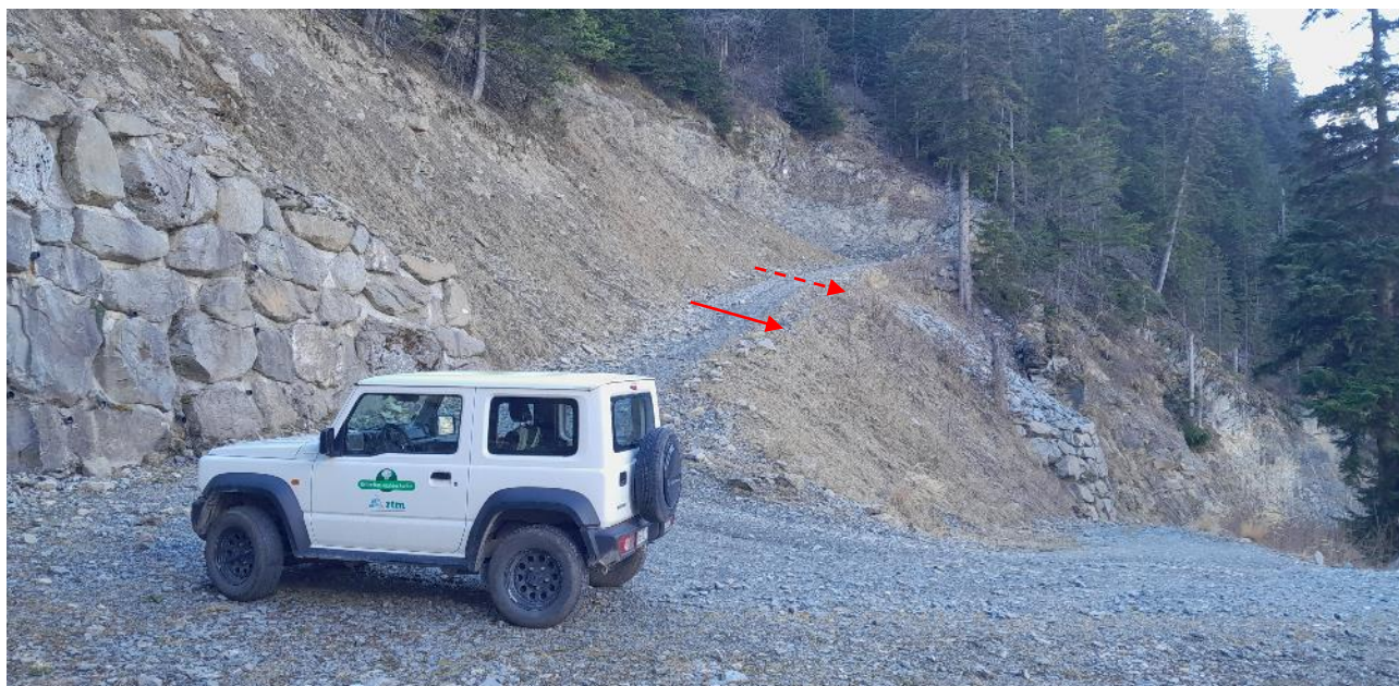
Figure 5 : Renvois d'eau à modifier et ajouter en amont du lacet 6
